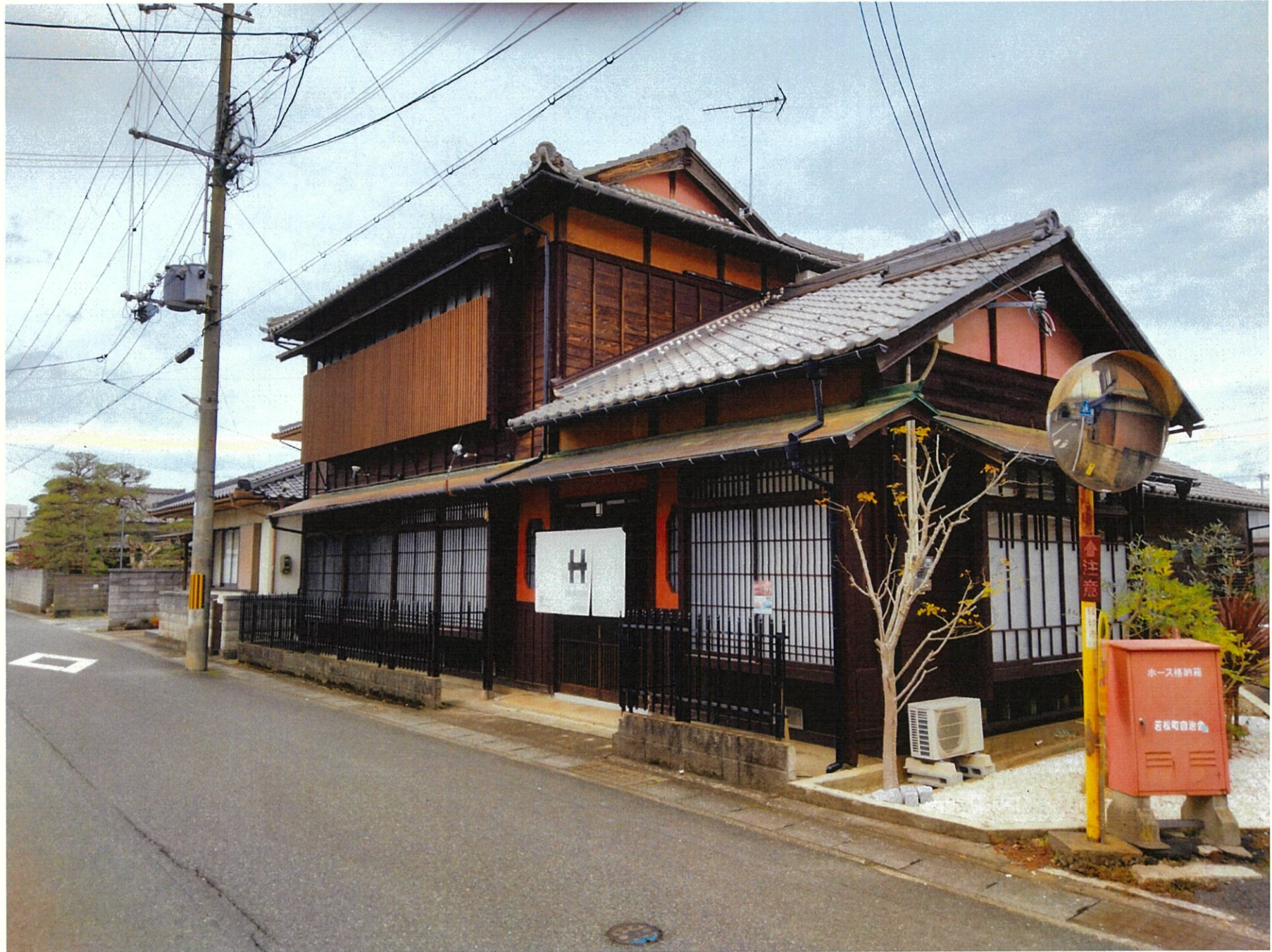
建物玄関側斜め前
